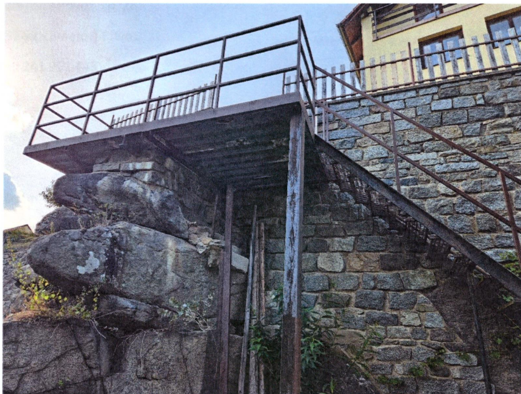
Fotografie ocelobetonové vykonzolované terasy
