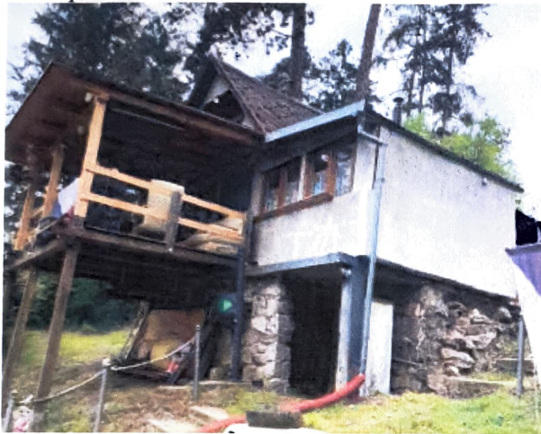
stavba pro rodinnou rekreaci č.ev.110
